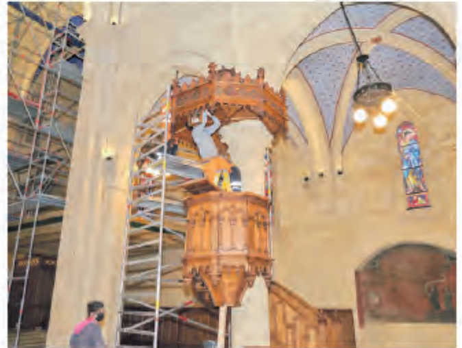
La chaire du XIX e siècle a été démontée pièce par pièce et remise en état.
