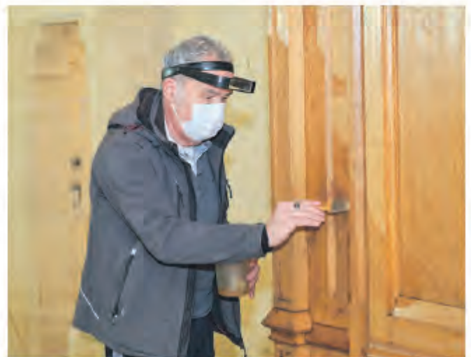
Le restaurateur de meubles Christian Schouwey cire la porte du sas ouest.
